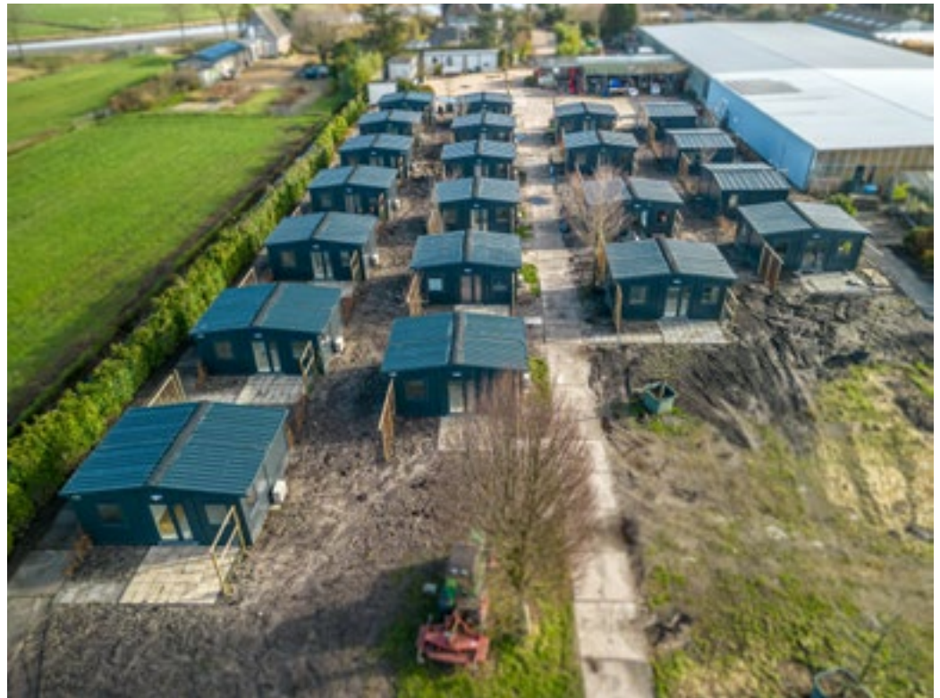
De 21 ecocabins in de vrije sector aan de Loodijk (foto: Wijdmeren van Boven, Marco van der Roest)
